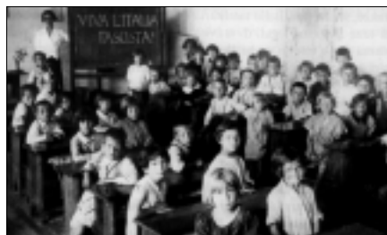
La scuola elementare di Doberdo.
